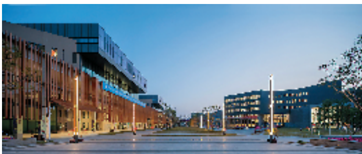
生长的建筑:建筑的活性与城市空间 港中大
