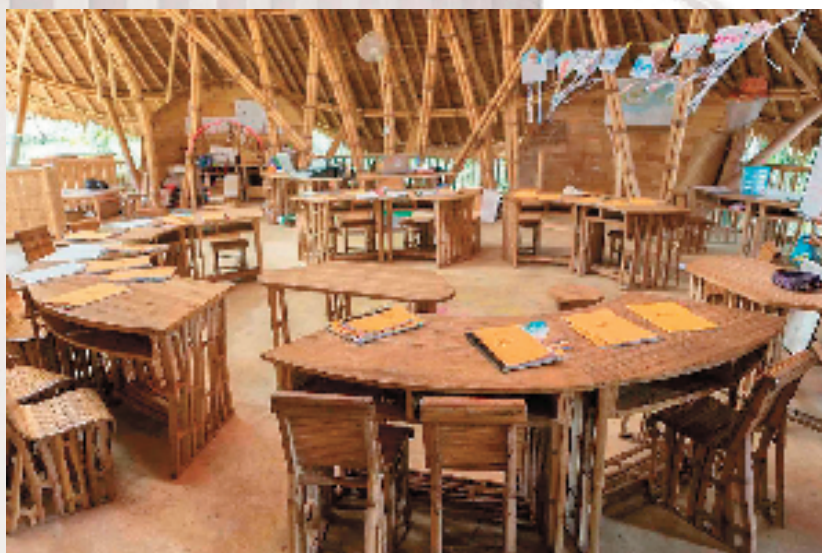
校园建筑的结构,除了混凝土基础外,其它都是用竹子手工制作的。
